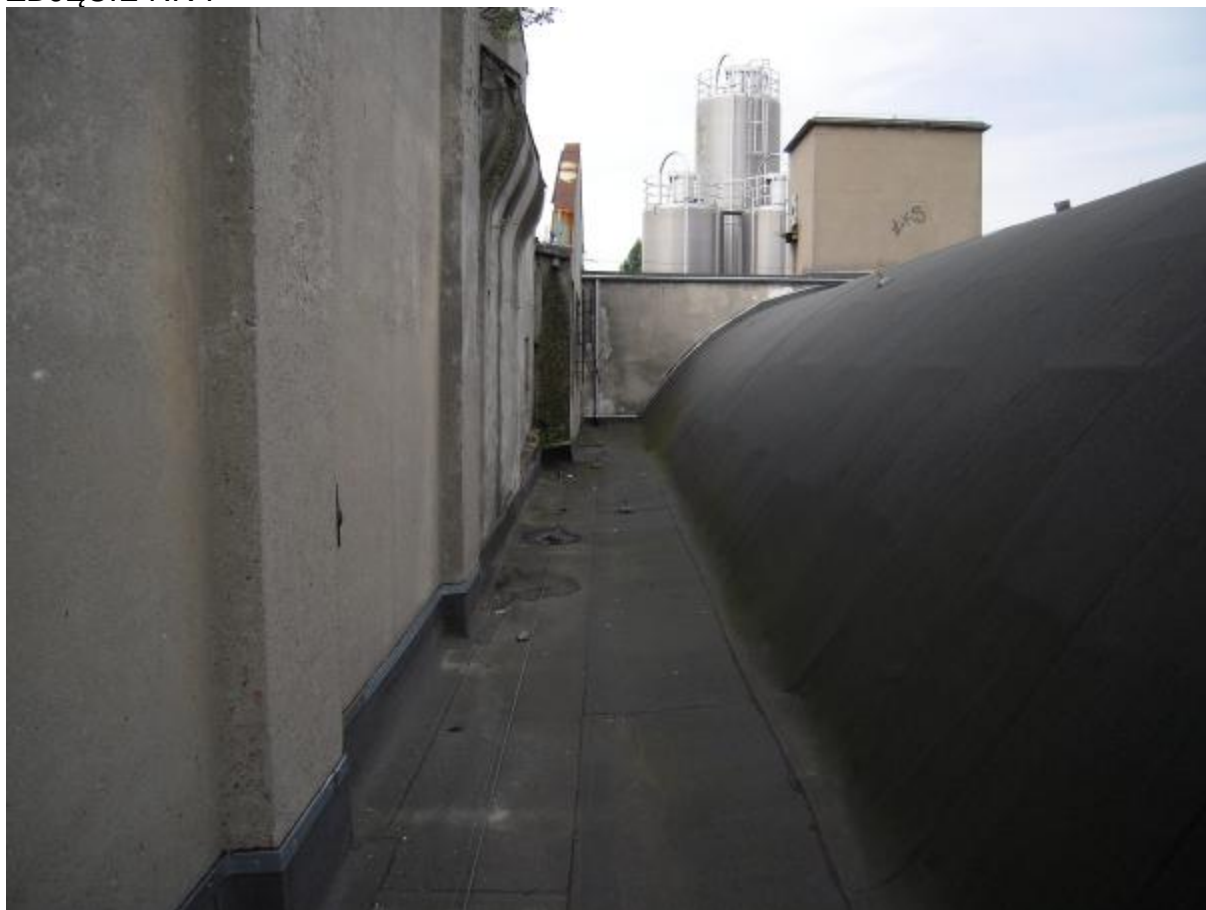
DACH WIDOK OD STRONY WSCHODNIEJ
