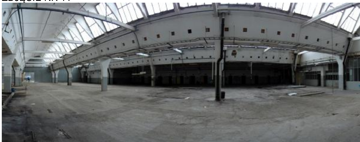
WNĘTRZA HALI BUDYNEK NR 9 WIDOK W STRONĘ SILOSÓW
