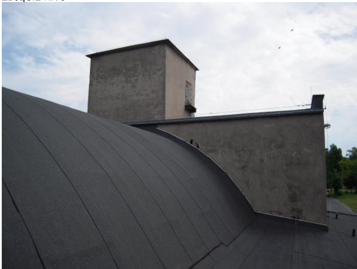
DACH WIDOK OD STRONY ZACHODNIEJ NA I PIĘTRO I WIEŻE Z CZERPNIAMI POWIETRZA
