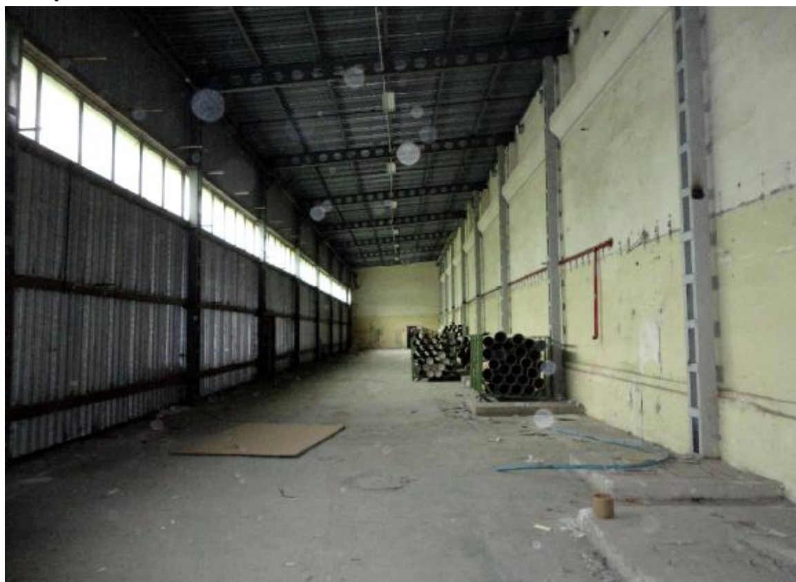
WNĘTRZE BUDYNKU NR 10
