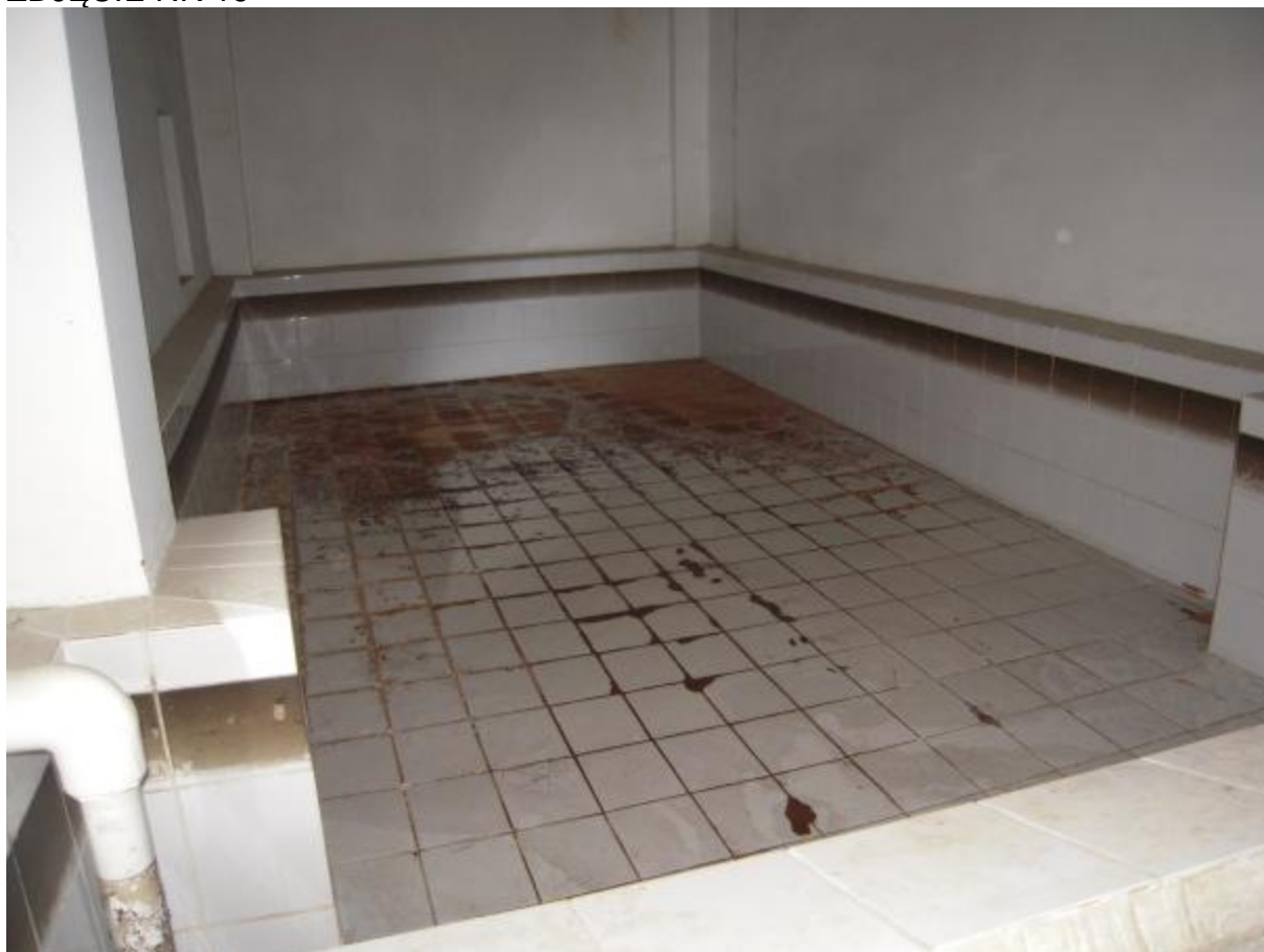
POMIESZCZENIE Z BASENEM I PIĘTRO BUDYNEK NR 9
