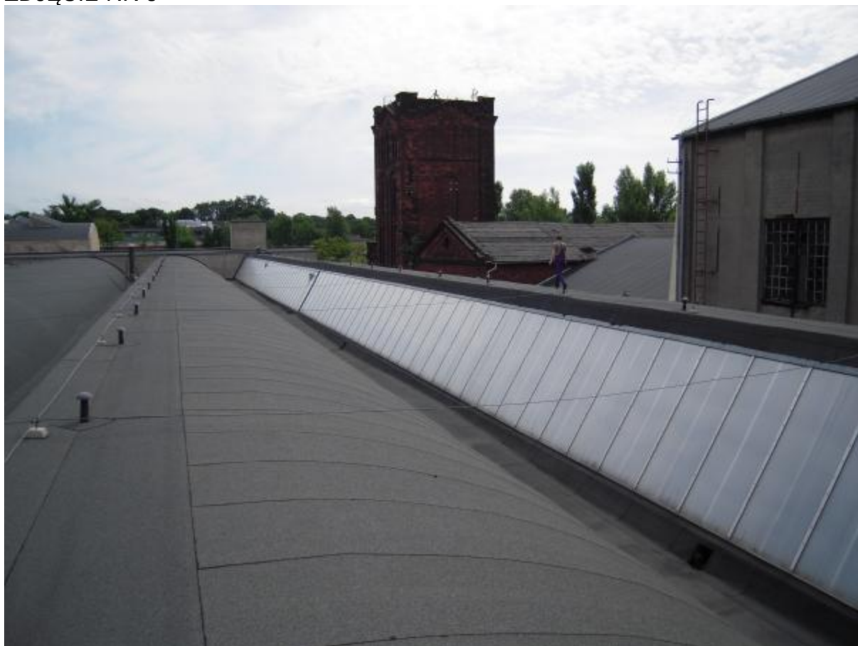
DACH WIDOK OD STRONY ZACHODNIEJ
