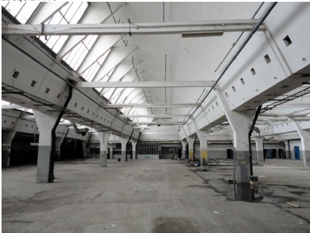
WNĘTRZA HALI BUDYNEK NR 9
