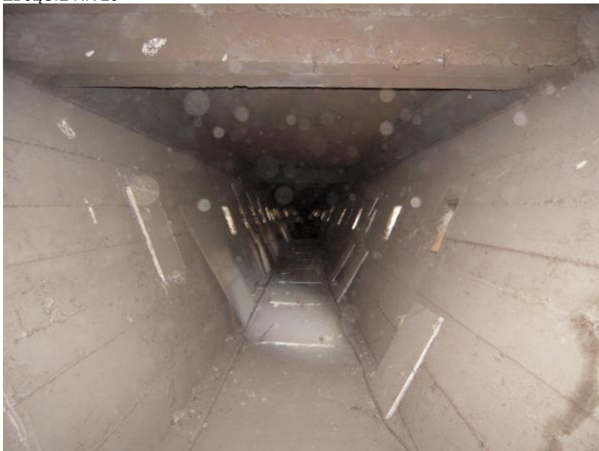
WNĘTRZE KANAŁU BUDYNEK NR 9
