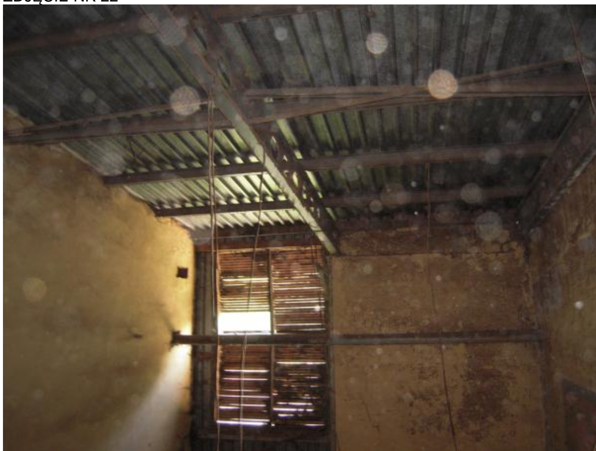
CZERPNIĄ W ŚCIANIE PÓŁNOCNEJ BUDYNKU NR 10
