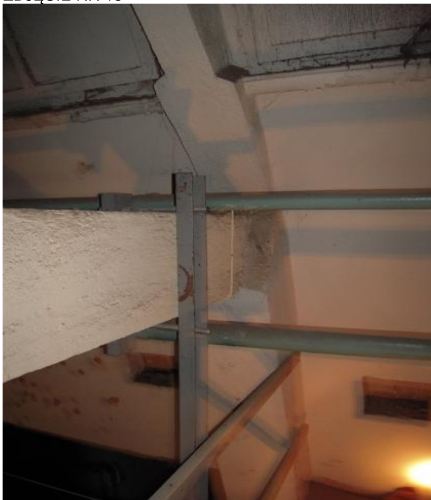
DETAL OPARCIE SZEDU I KONSTRUKCJA GŁÓWNA
