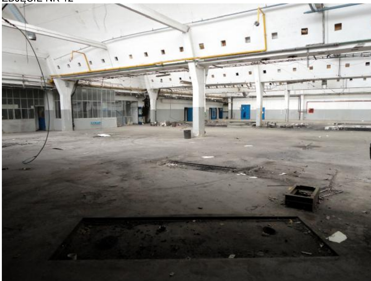
WNĘTRZA HALI BUDYNEK NR 9 WIDOK W STRONĘ POMIESZCZEŃ SANITARNYCH
