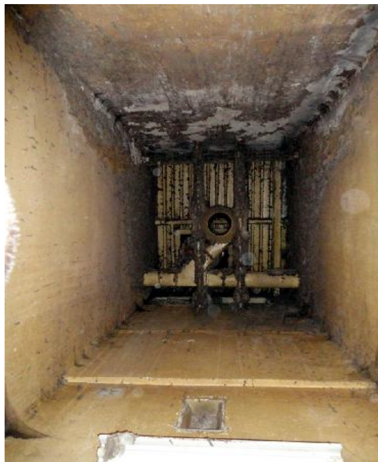
ZDJĘCIE NR 14 WENTYLACJA SILOSU
