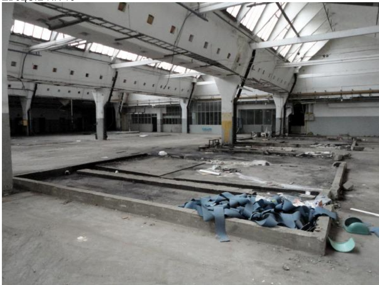
WNĘTRZA HALI BUDYNEK NR 9
