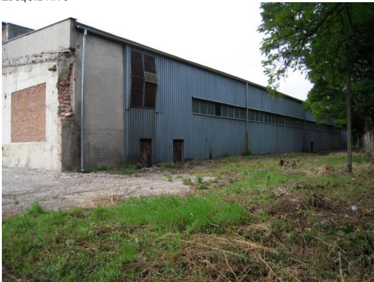
ELEWACJA PÓŁNOCNA WIDOK PÓŁNOCNO-WSCHODNI
