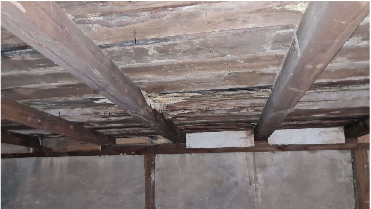
FOT.5. Pleśń i zagrzybienia oraz zawilgocenia od spodu więźby
