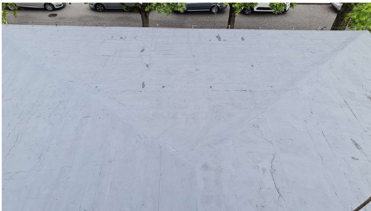
FOT.4. Widoczne pęknięcia pokrycia dachu niższego
