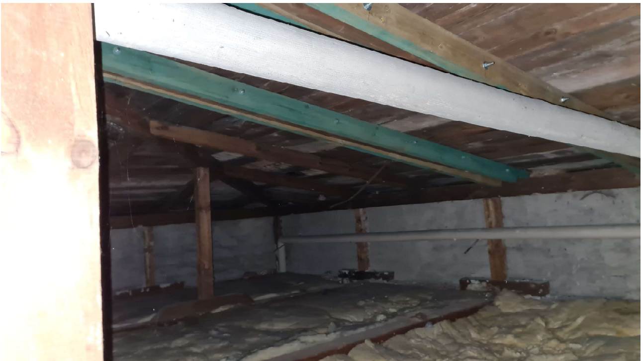
FOT.8. Pleśń, zagrzybienia i zawilgocenia od spodu wieży niższej
