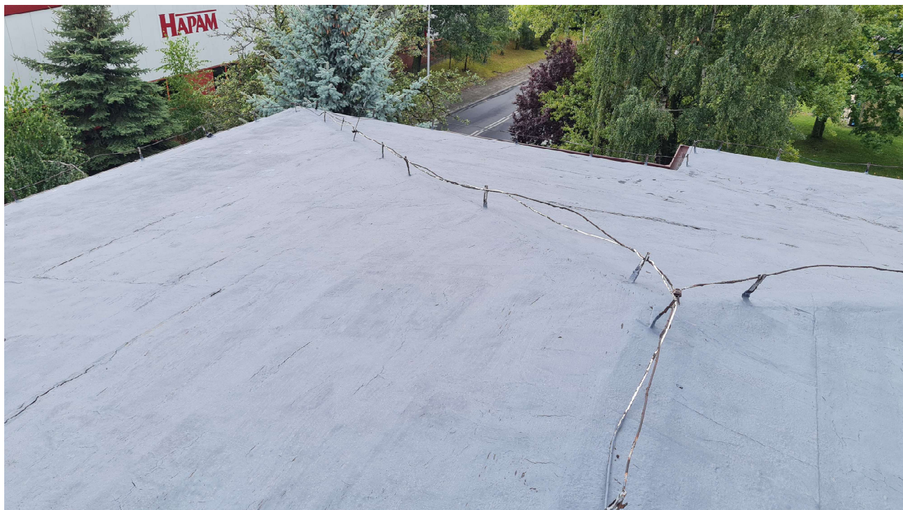
FOT.1. Widoczne pęknięcia pokrycia dachu od strony ulicy i szczytu zachodniego
