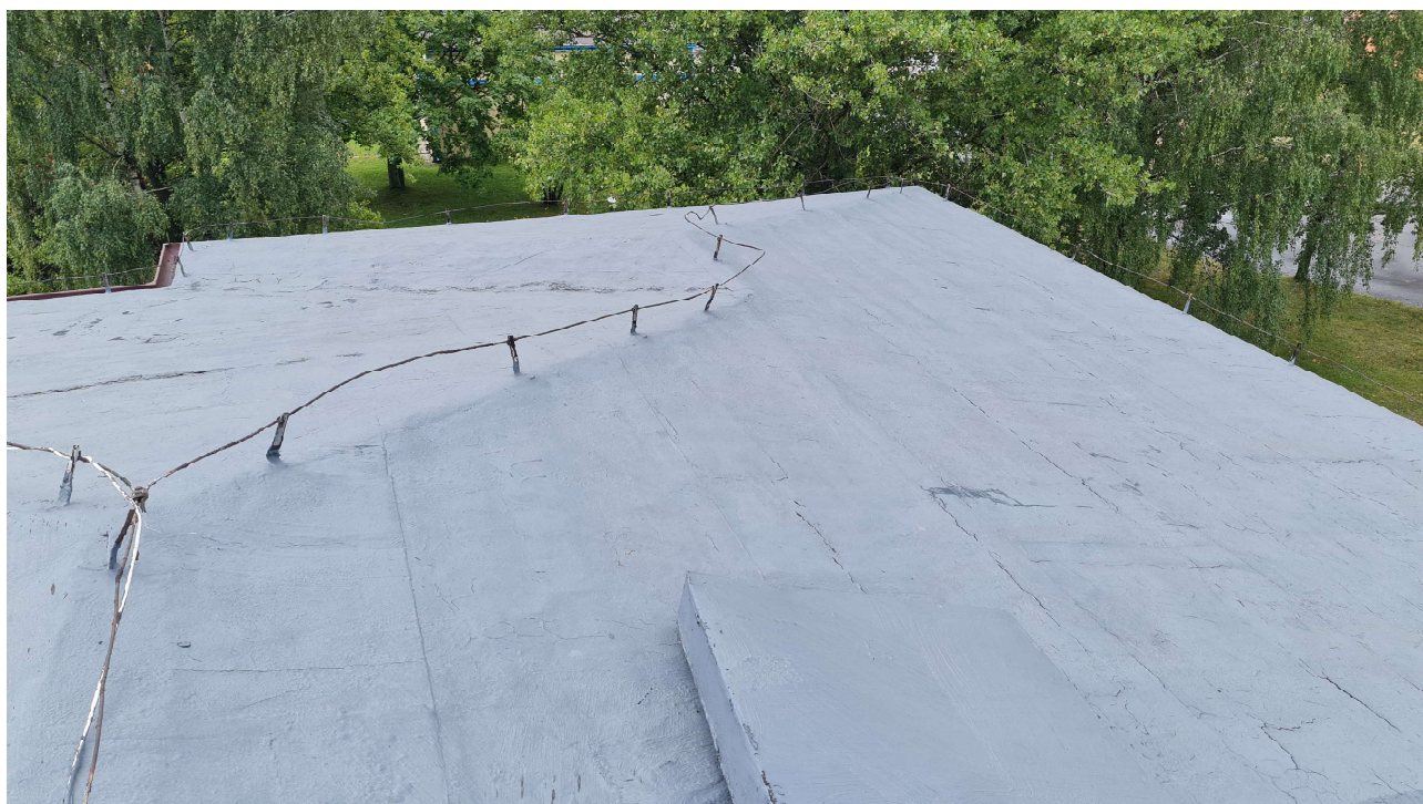
FOT.2. Widoczne pęknięcia pokrycia dachu od strony tylnej/ północnej/ i szczytu zachodniego
