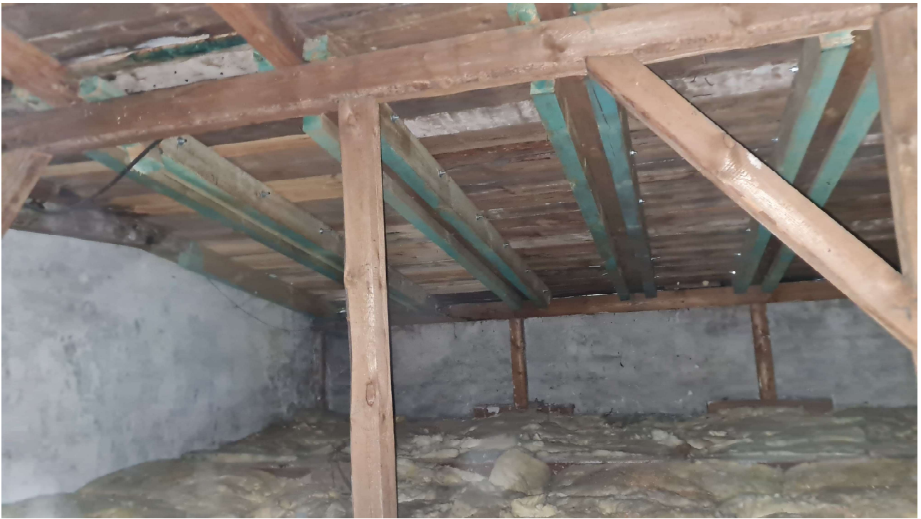
FOT.7. Pleśń, zagrzybienia i zawilgocenia od spodu wieży niższej
