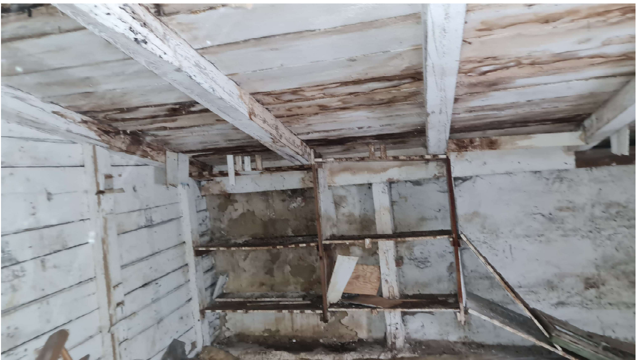
FOT.6. Pleśń i zagrzybienia oraz zawilgocenia od spodu więźby
